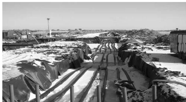
380kV地中送電線の布設
