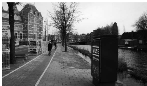
配電線の路上変圧器
