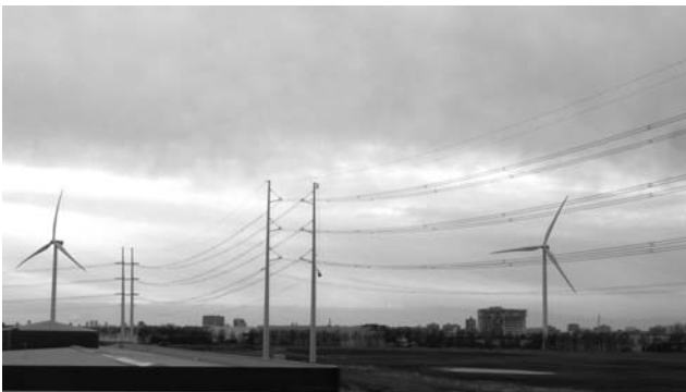
建設されたウィントラック鉄塔と風力発電
