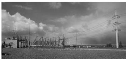
この変電所は、JEIC NEWS第28号で紹介したランドスタット380kVプロジェクトの一環として拡充されたばかりの新しい設備です。変電所に接続している380kVの架空送電線には、新たに開発された磁界低減型鉄塔（Wintrack pylon：ウイントラック鉄塔）が採用されており、変電所敷地内には組み立て前のマストが数本置かれていました。
