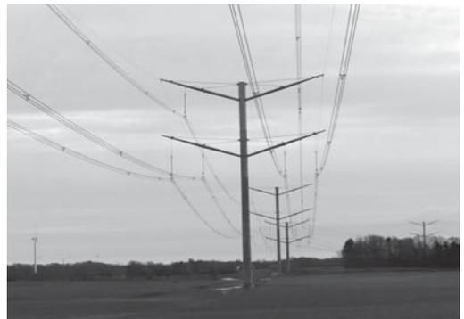
イーグルマストを採用した理由も、景観を重視するという政策が背景にあります。従来の標準的な400kV鉄塔は1回線水平配列ですが、イーグルマストの形状は2回線（3導体／相）3角配列で、腕金の下面は黒っぽく塗色されており、遠くから見ると塔体も腕金も細く見えます。建築家やデザイナーから「人間には黒色しか見えず感覚的にプラスイメージだ」とアドバイスされたそうです。なお、景観対策として採用したイーグルマストですが、磁界の強さについて従来の鉄塔と比較すると、鉄塔中
